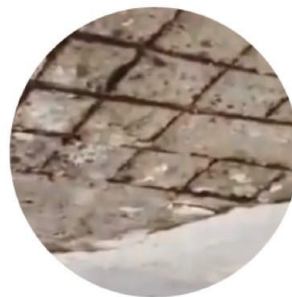
обломки штукатурки и дерева от сноса зданий и сооружения
